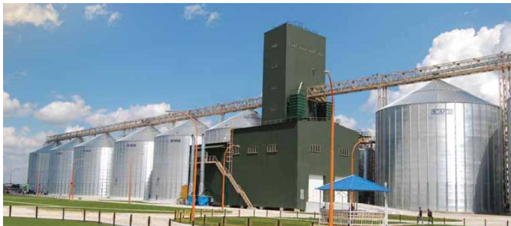
Rys. 1. Bateria siłosów metalowych przeznaczonych do magazynowania zbóż Fig. 1. Battery of metal silos for grain storage
