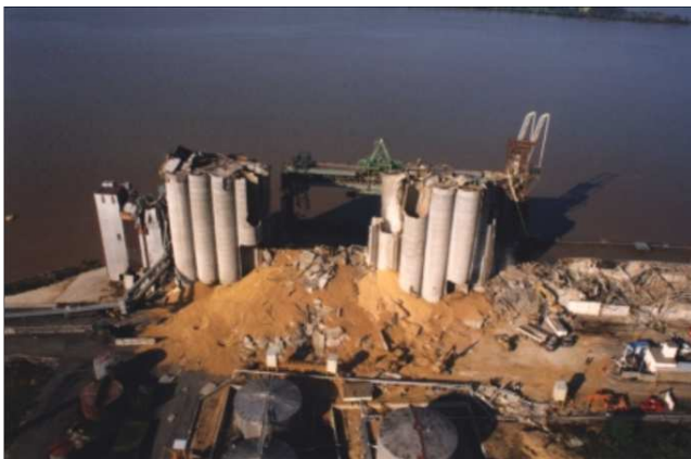
Rys. 2. Zniszczenia spowodowane wybuchem pyłu w zespole silosów w Blaye (Francja) Fig. 2. The destruction caused by the explosion of grain dust in silos in Blaye (France)
